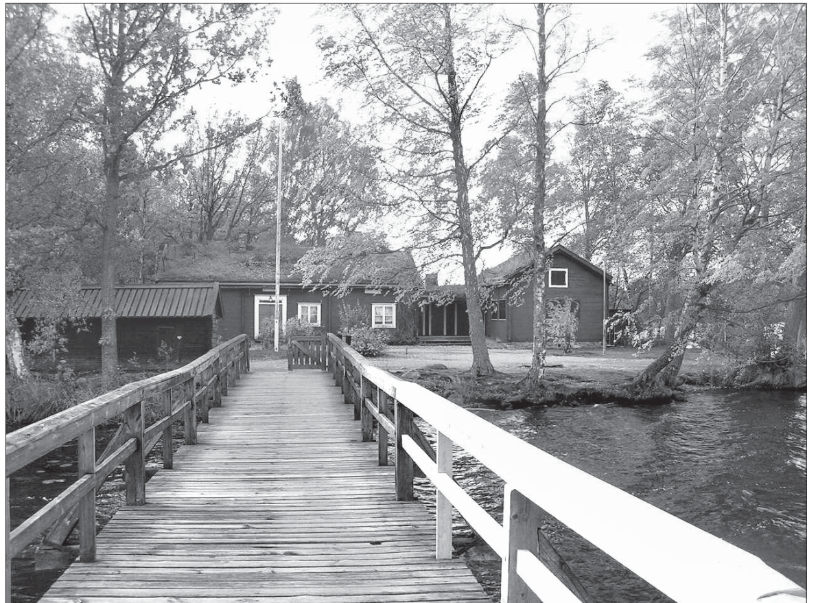
Швэды ўсё будуць з дрэва. Студэнцкі пансіят у Кронабэргу. Будынкi, як амаль паўсюдна ў швэдзкай правінцыі, пафарбаваныя ў бурачны колер.
